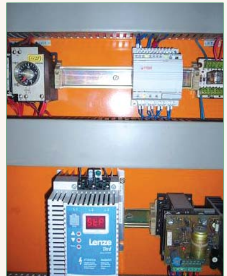
Rys. 5. Szafa sterująca z przełącznikiem NEED i przetwornicą częstotliwości
