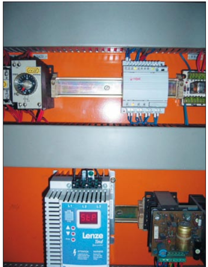
Szafa sterująca z przekaźnikiem NEED i przemiennikiem częstotliwości
